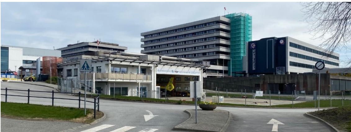
Foto 17: Sykehusomtata har variert bebyggelse fra ulike tider, som kan romme variert bruk, midlertidig eller permanent. Foto: Sigurd Nedrelid.
