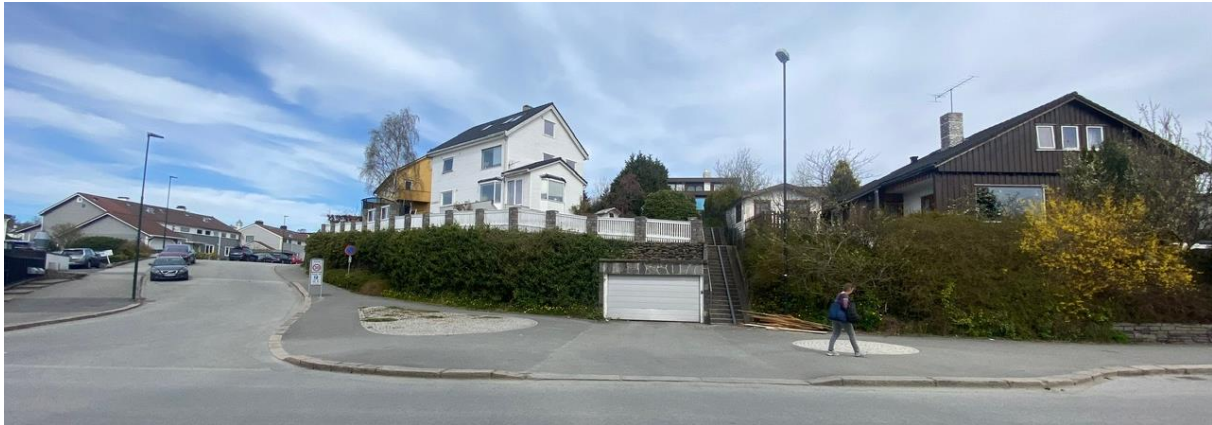
Foto 28: Bebyggelse på Våland, som er preget av eneboliger og rekkehus. Våland beskrives med litt bedre levekår, enn nabolagene i sør. Foto: Sigurd Nedrelid.
