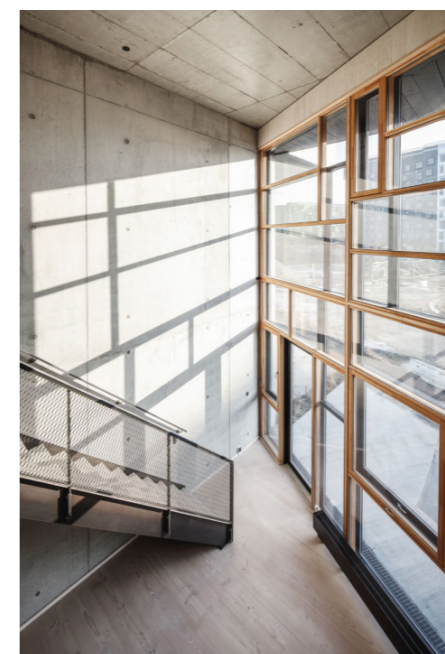
Upcycle studios av Landager group. Prisivinnende gjenbruksprosjekt. Her er både betong og ulike bygningselementer gjenbrukt.
