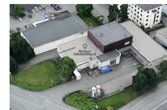
◀ Bygget sett fra Armauer Hansens vei i nord
