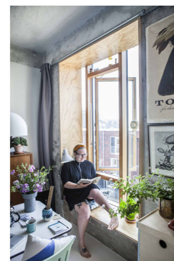
Utvendig etterisolering. Her er vinduene i påføringen større for å vise det opprinnelige bygget og gi hybelen nye kvaliteter. Rehabilitering av konstabelskolen, København. Tegnestuen Vandkunsten
