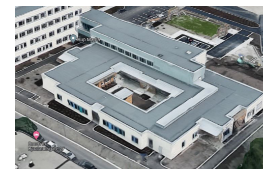
◀ M og N-blokken sett fra Bjaalands-gaten, og flyfoto fra sør-vest
