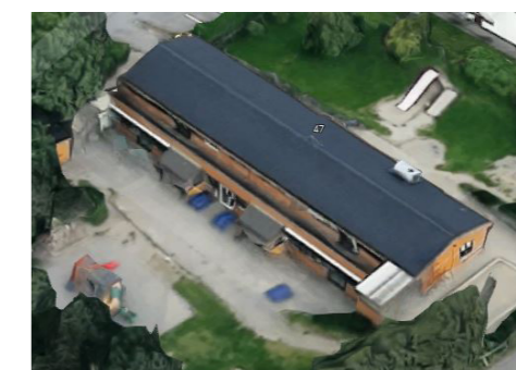
◀ Prosjektkontoret sett fra vest
