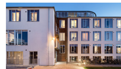
Utvendig etterisolering. Her er vinduene i påføringen større for å vise det opprinnelige bygget og gi hybelen nye kvaliteter. Rehabilitering av konstabelskolen, København. Tegnestuen Vandkunsten
