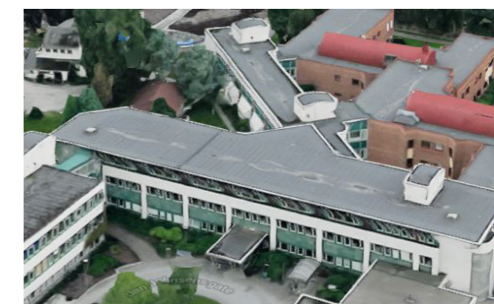
◀ Bygget sett fra nord-vest
