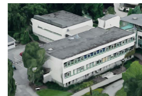
◀ Bygget sett fra nord-vest
