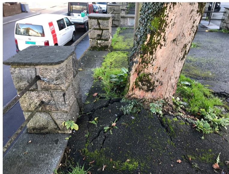
TRE SPRENGER MUREN
